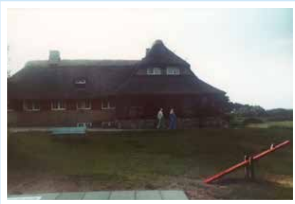
Set fra syd med legeplads og fløjbygning
