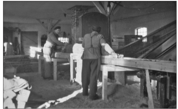
7.28 - Flygge Jørgensen og en hjælper saver træstammer ud til brædder. - tb
