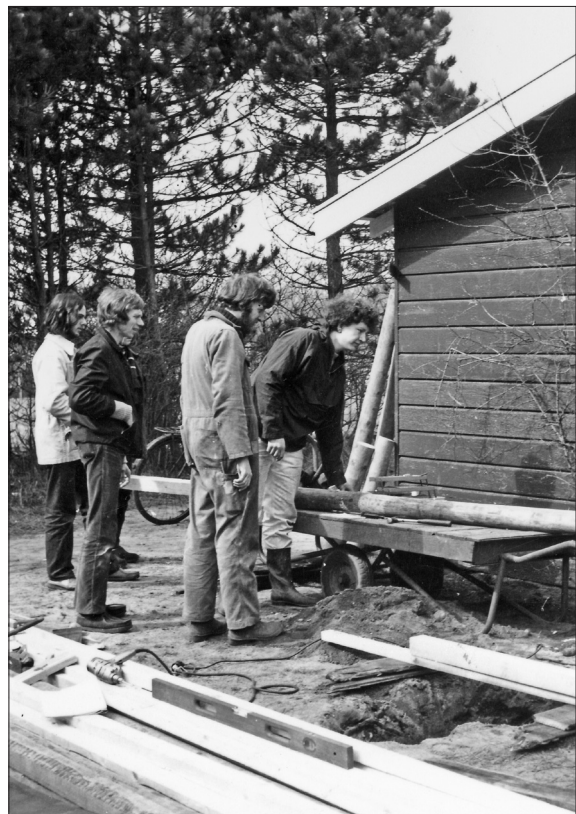
12.97 - 12.98 - 12.99 - Der var brug for både god arbejdskraft men også nogen erfaring for at få træpavillonerne istandsat. - tb
