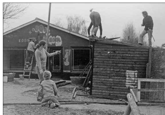
12.89 - Købmandsforretningen bliver ombygget til receptionslokaler for feriebyen. - tb
